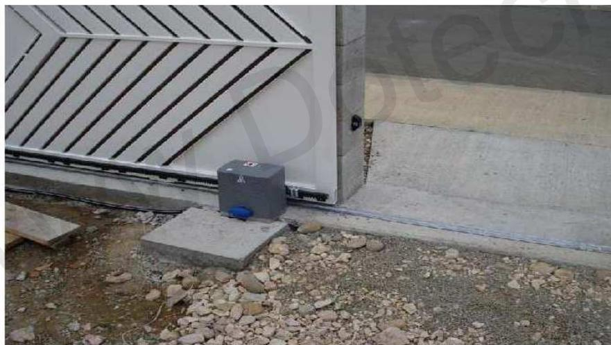
**IMPORTANTE:** Equipo diseñado para un peso de arrastre de 300 kilos, esto es equivalente al peso físico del porton multiplicado por dos.
